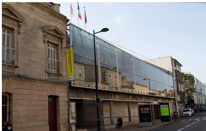
Les Archives départementales de la Gironde à Bordeaux - © H. Chassagnac / FFG
